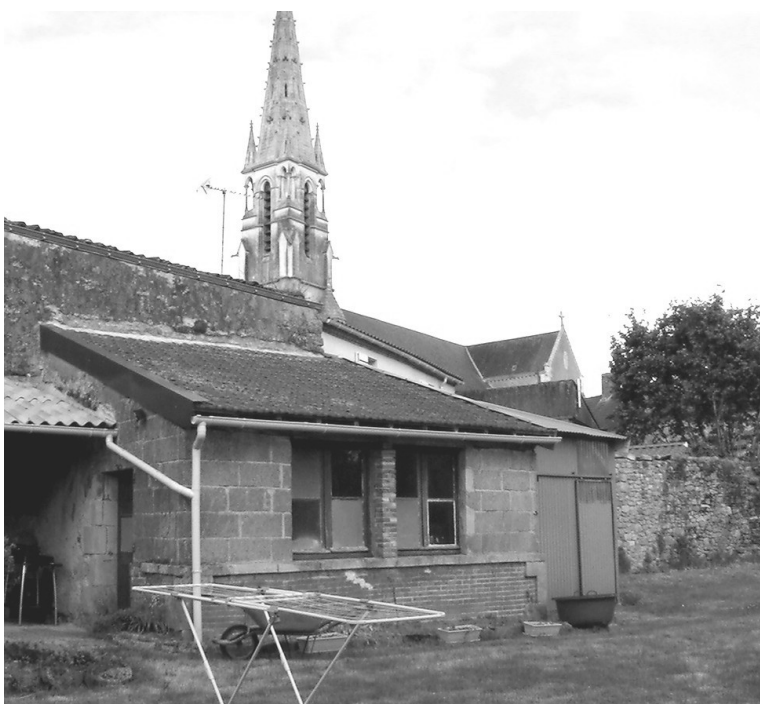
La saboterie était dans le petit bâtiment en parpaings
