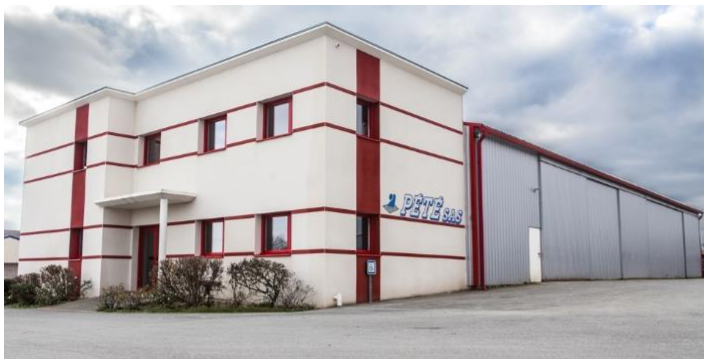
Bâtiment Entreprise PÉTÉ SAS – ZA La Coussaie - Bournezeau
