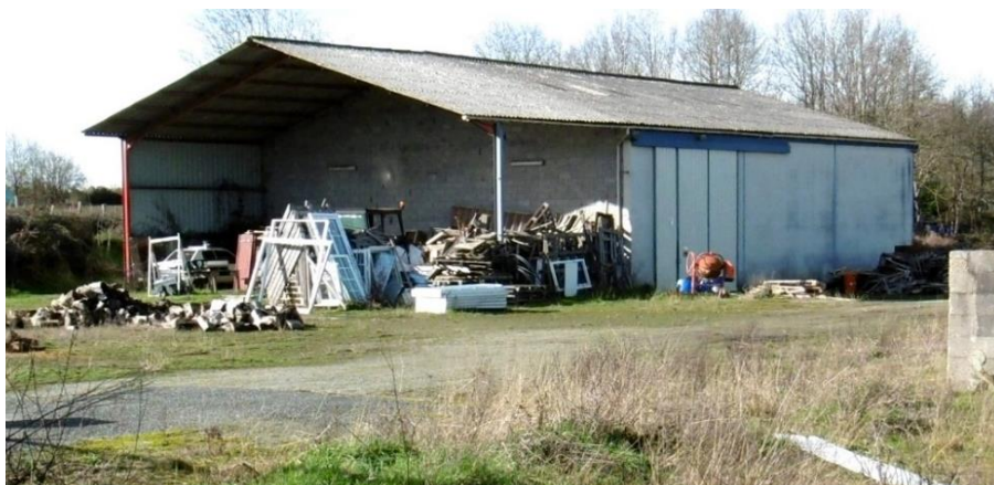
Photo du bâtiment prise en janvier 2024.
